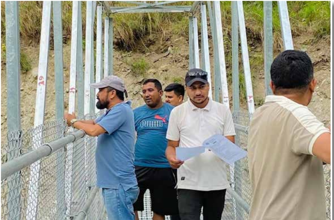
फिक्कल गाउँपालिका-४, खाडसाङको साँधुरीमा निर्मित भोलुगे पुल
